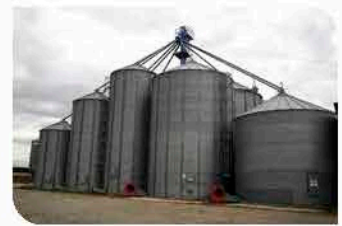
Figura 3.19. Silos de diversos tamaños.
